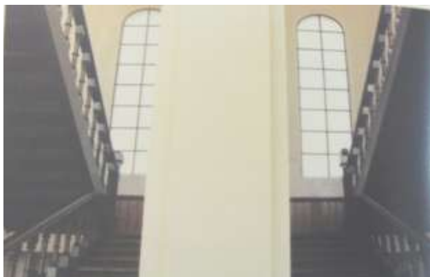
Escadarias separadas por parede de alvenaria marcando a separação de meninos e meninas – Grupo Escolar de Amparo. Fonte: CORRÊA, 1991, p. 40.
