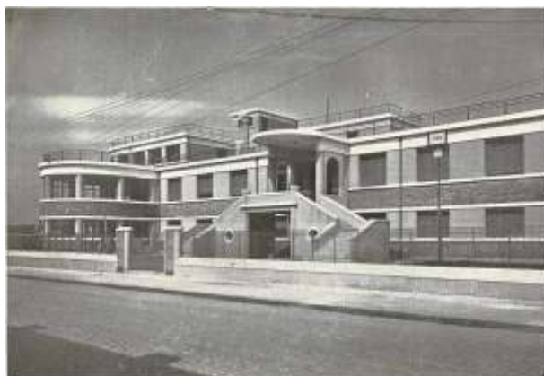
Fachada da parte da frente do prédio. Cinquant`anni di lavoro degli Italiani in Brazil V.I. Lo stato di São Paolo – Ed. Società Italiana Sao.Paulo 1936. Figura 01.
